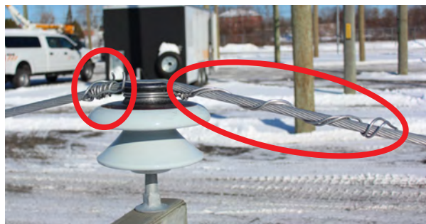
Relâchement des fils d'attache
